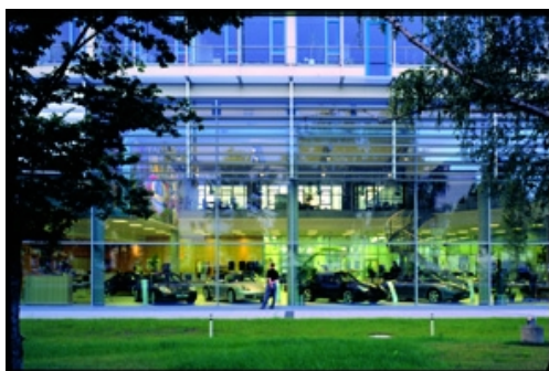
Der nach Süden ausgerichtete, acht Meter hohe Verkaufsraum ist über seine ganze Höhe verglast und wirkt daher sehr großzügig. Der hohe Lichttransmissionswert von 79% der UNITOP-Verglasung ermöglicht eine natürliche Belichtung bis in die Raumtiefe.
